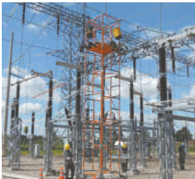
Trabajos de mantenimiento en la Subestación Eléctrica Urubó.
