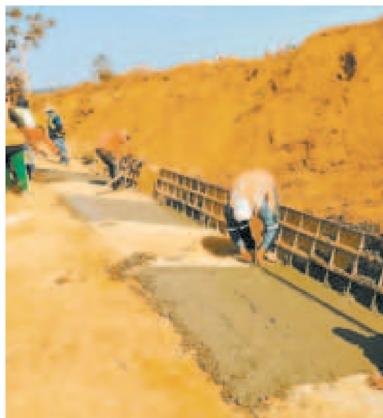
Los trabajos de la ABC en Pando.
