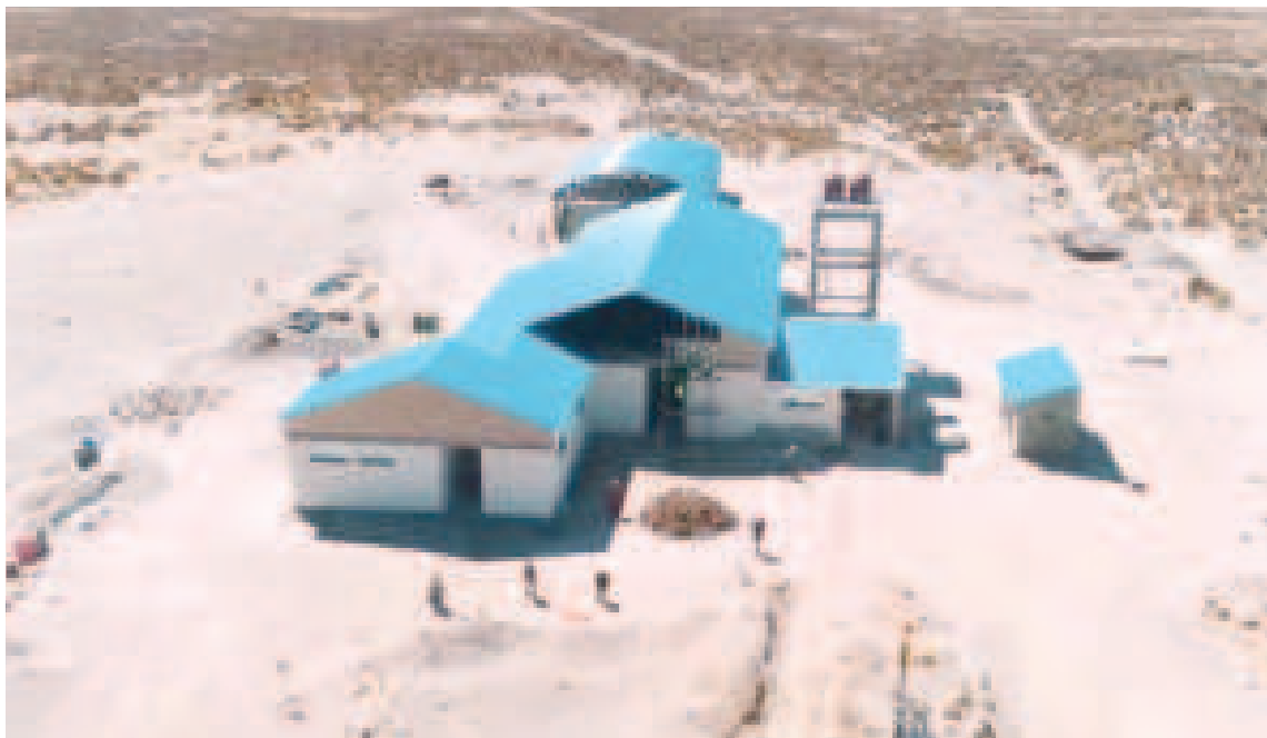
La infraestructura física de la planta industrial ya se encuentra concluida.
