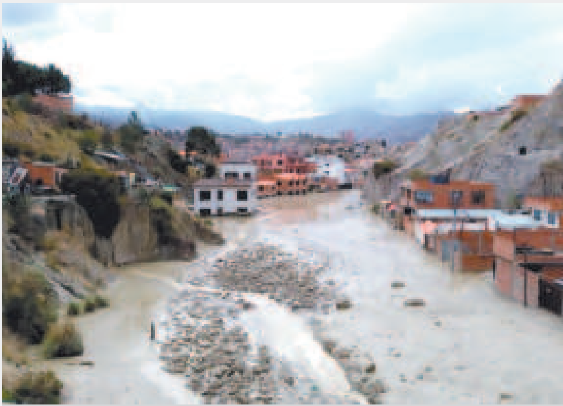
Estragos en la zona Bajo Llojeta debido a un deslizamiento.
