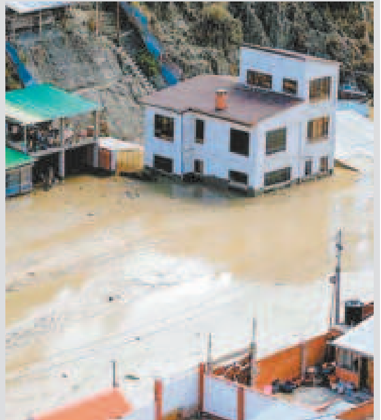
La zona afectada ya no es habitable.
