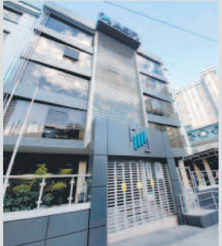
La fachada del edificio de la ASFI en La Paz.
