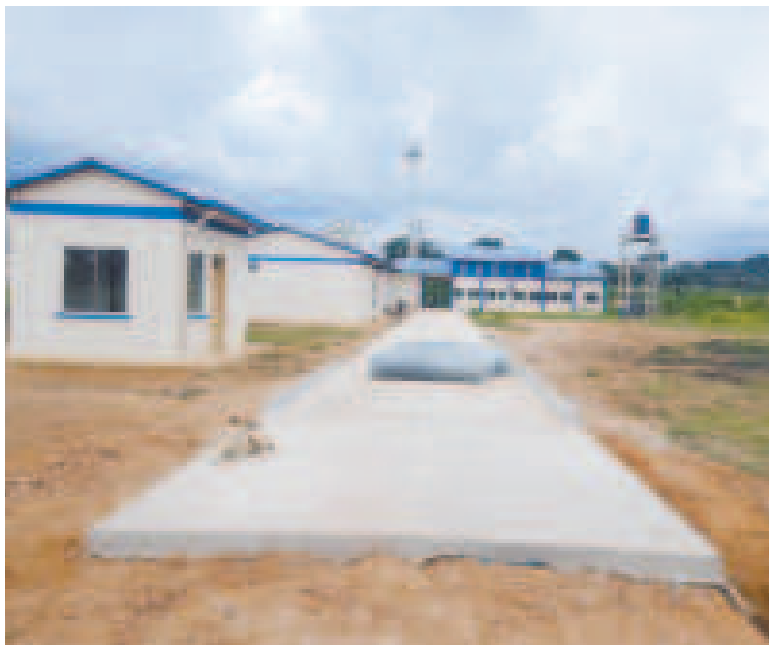
Los trabajos de construcción en una parte del complejo industrial.
