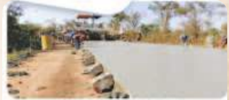
CONSTRUCCIÓN CARRETERA PUERTO IBICO - EL SEMA. Inversión: Bs.521,3 millones
