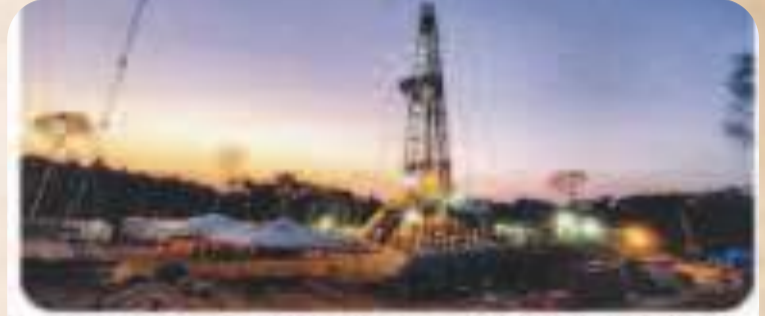
PERFORACION POZO TOMACHKI INVESTIGACION ESTRATIGRAFICA EN PANDO (MANURIP). Inversión: Bs.271,8 millones
