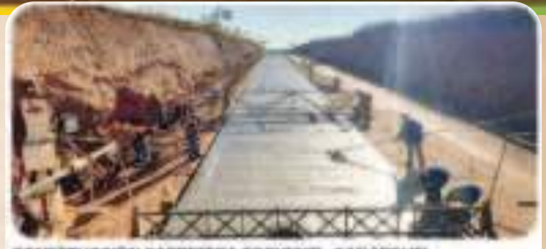
CONSTRUCCIÓN CARRETERA FORVENIR - SAN MIGUEL. Inversión: Bs.795,5 millones
