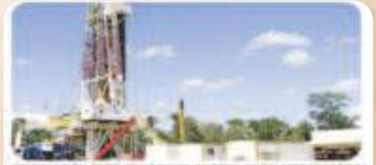
PERFORACION POZO TOMACHKI INVESTIGACION ESTRATIGRAFICA EN PANDO (MANURIP). Inversión: Bs.229,0 millones
