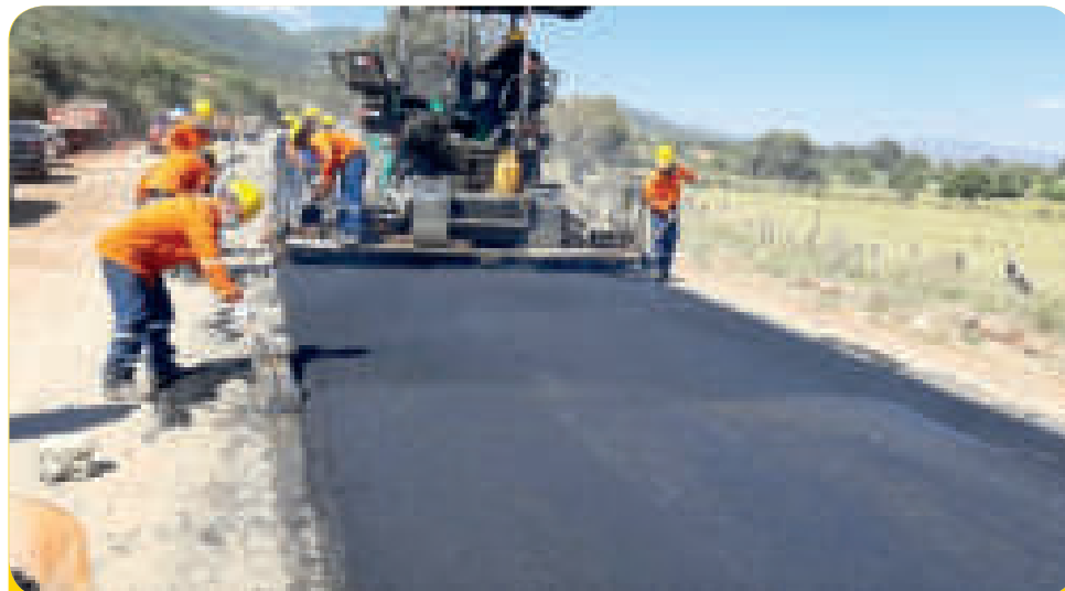
Rehabilitación de vías en el oriente boliviano.
